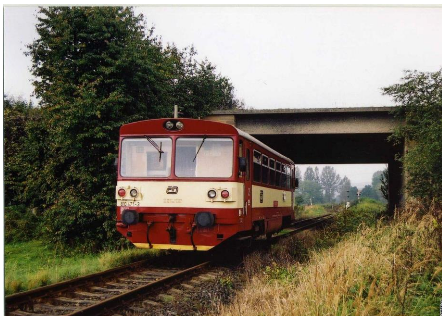
Obrázek č. 29: Zachovalé přemostění dálnice nad dráhou u Velkých Opatovic (Martin Janoška, iDNES.cz)
