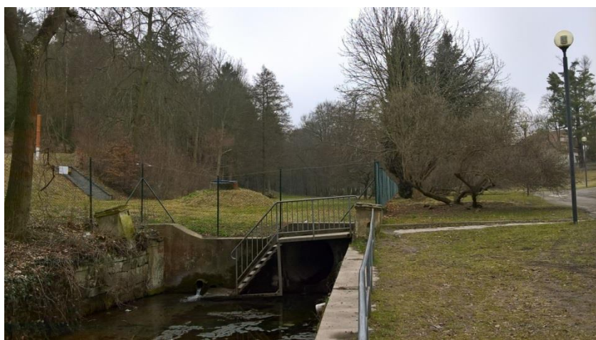
Obrázek č. 63: Vodní tok v zámku v potrubí jako zdroj pitné vody pro vodovod Boskovice, v místech starého splavu (vlastní)
