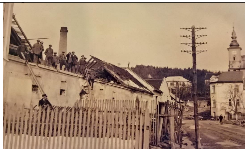
Obrázek č. 19: Výstavba sokolovny v části bývalého pivovaru (Památník Města Velké Opatovice)
