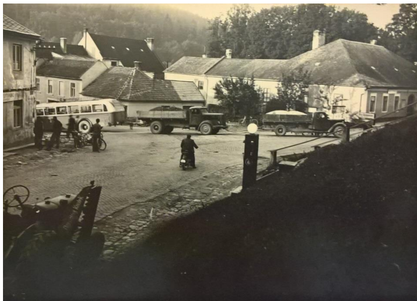
Obrázek č. 64: Prostor pod kostelem s původní benzinkou sloužící do roku 1969 (foto asi z roku 1942) (Památník Města Velké Opatovice)
