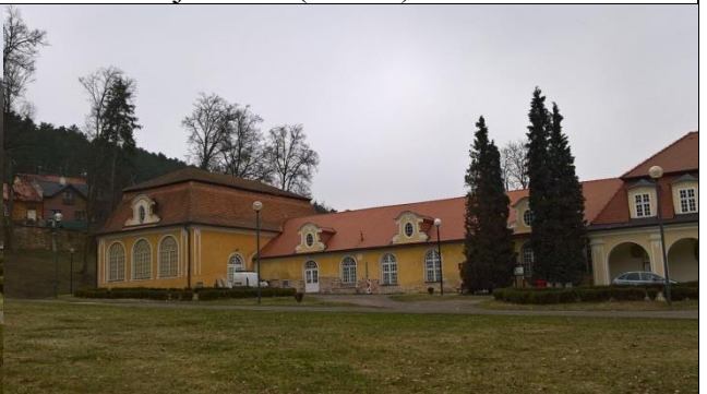
Obrázek č. 86: Pohled na západní trakt s dostavěnou částí bývalé tělocvičny, dnes vnitřním kinem (vlastní)
