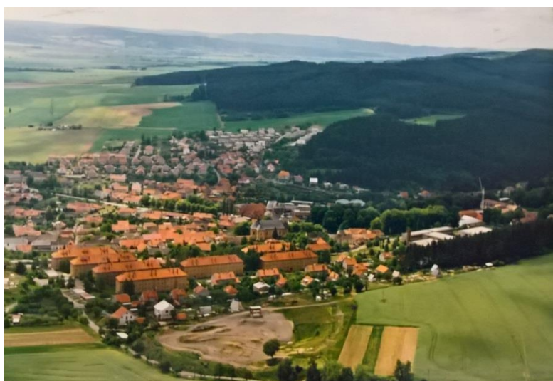
Obrázek č. 73: Výstavba Ústavu sociální péče Paprsek mezi lety 1997 – 2000 na severu obce (Památník Města Velké Opatovice)
