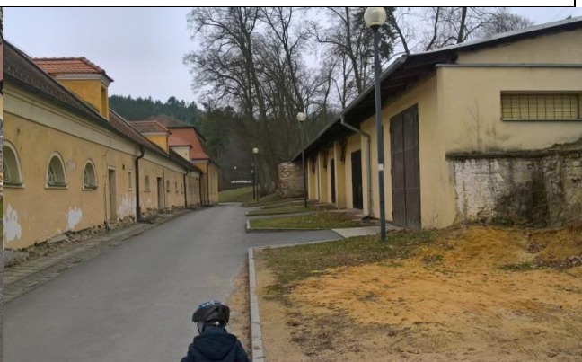
Obrázek č. 84: Okolí zámku se zázemím pro stavební firmu, severní okraj zámku (vlastní)
