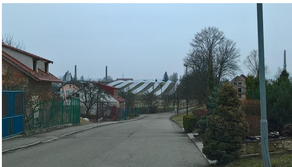
Obrázek č. 130: Pohled na solární elektrárnu v jižní části obce z ulice (vlastní)
