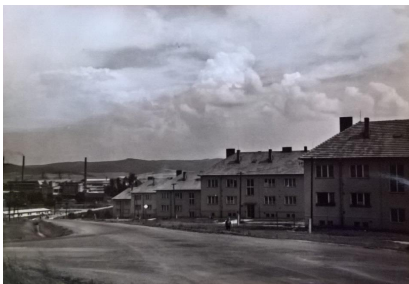
Obrázek č. 32: Dokončená výstavba bytových jednotek na východě obce v roce 1960, ulice Na Zkratce (Památník Města Velké Opatovice)
