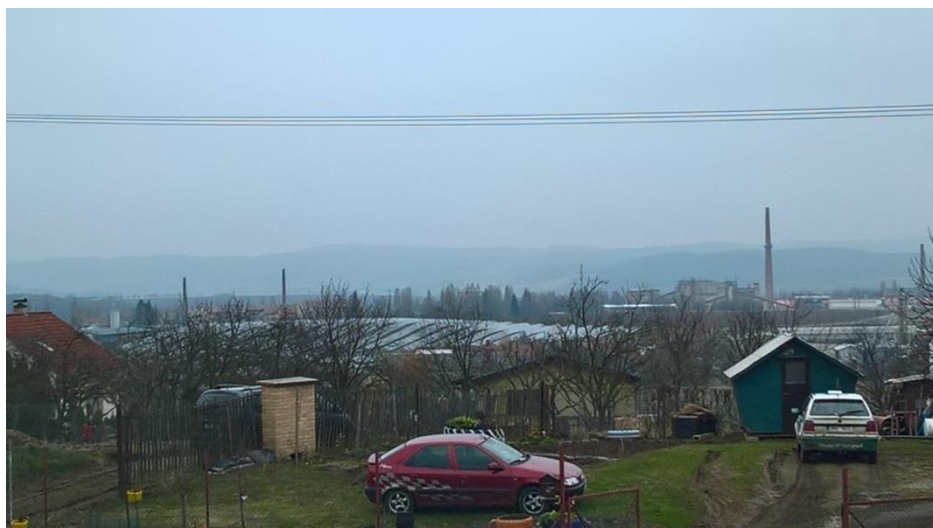
Obrázek č. 131: Solární elektrárna na jihu obce (vlastní)
