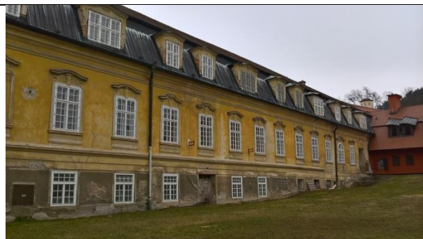
Obrázek č. 87: Jižní část zámku s přechodem do zadní části MKC (vlastní)
