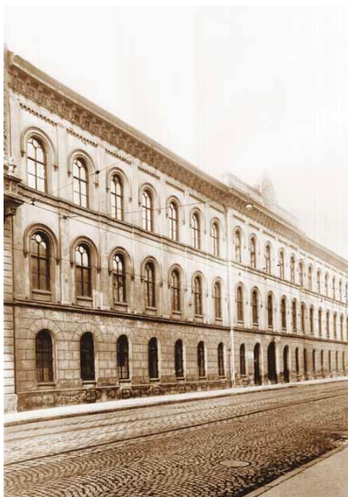
Budova ZŠ pro nevidomé a slabozraké žáky v Brně na Veleřské ulici 236
