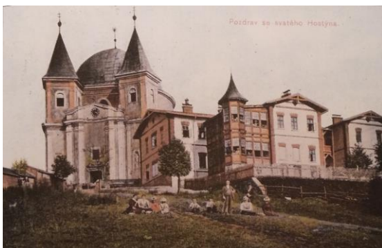
Obr. č. 49 Hostinec v blízkosti kostela po přestavbě řízené Otto Zemanem. Nedatovaný pohled.
