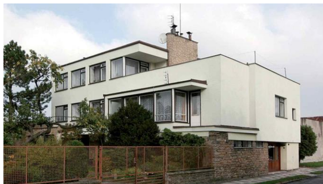
Obr. č. 67 Josef Maťa: Vlastní vila v Bystřici pod Hostýnem, stav v roce 2017.
