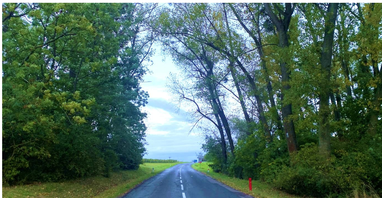
Obr. 34 Silnice spojující obce Perná a Klentnice rozděljuje biokoridor na dvě části a představuje významnou bariéru pro pohyb organismů. V zimním období dochází k údržbě komunikace, která působí jako stresový faktor pro okolní stanoviště, avšak samotnou vegetaci zásadně neovlivňuje, což dokládá dominance nitrofilních druhů v blízkosti silnice. (Foto autor, 28.9.2025)
