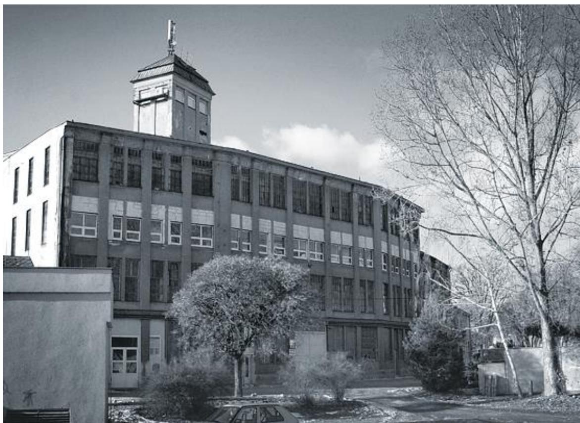
Obrázek 17 - Fabrika Svitavy před revitalizací, celkový pohled
