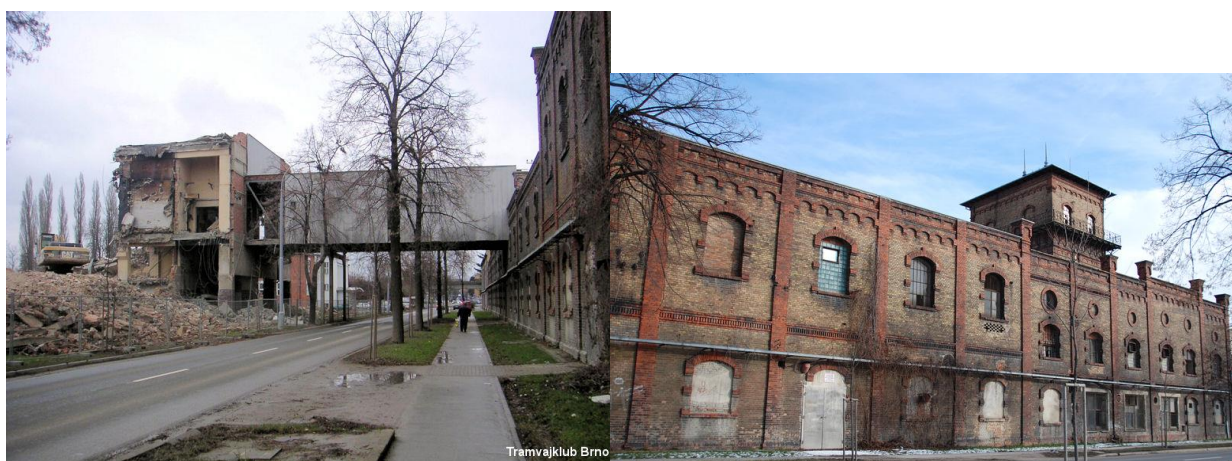
Obrázek 9 a Obrázek 10 – areál městských jatek v Brně před svou rekonstrukcí, Brno
